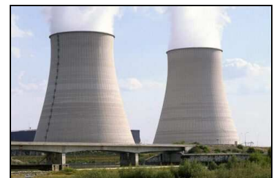
Tours de refroidissement d'une centrale nucléaire.
