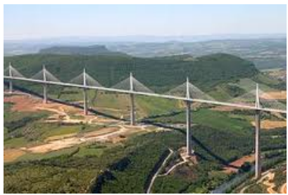
Viaduc de millau
