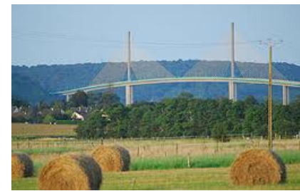
Pont de brotonne
