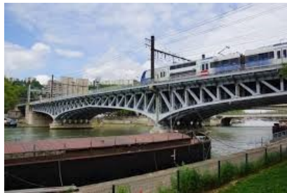
Pont train péniche
