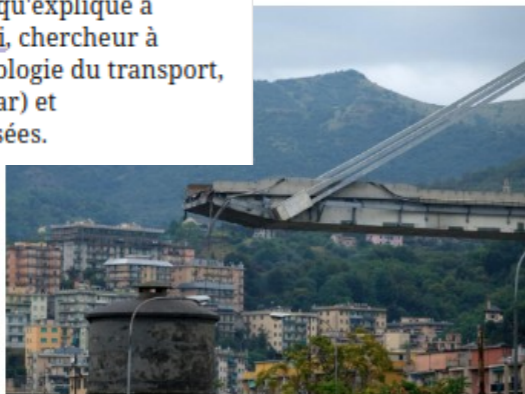
Le Pont Morandi après son effondrement le 14/08/2018. On distingue bien les poutres de béton précontraint qui jouent le rôle de haubans. / ANDREA LEONI / AFP
